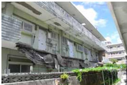
左の写真は昨年9月に発生した沖縄浦添市のマンション共用廊下の崩落現場の様子です。鉄筋コンクリートの廊下が無残にも崩れ落ちています。今年の西日本セミナーでは、この現場を見学して、崩落に至った建物管理のあり方について学びます。また翌日は、組合主体のマンション管理についてパネルディスカッションを行い、さらに沖縄のマンション管理の実態に関する講演を予定しています。
